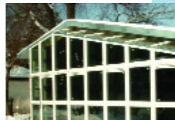
Spațiu solar atașat clădirii experimentale INCERC
